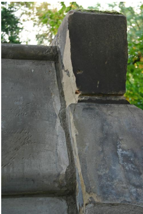
Linke Dachfläche mit neuer Verfugung
