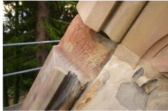
B. rechtwinklig ausgearbeitete Vierungsniesche
