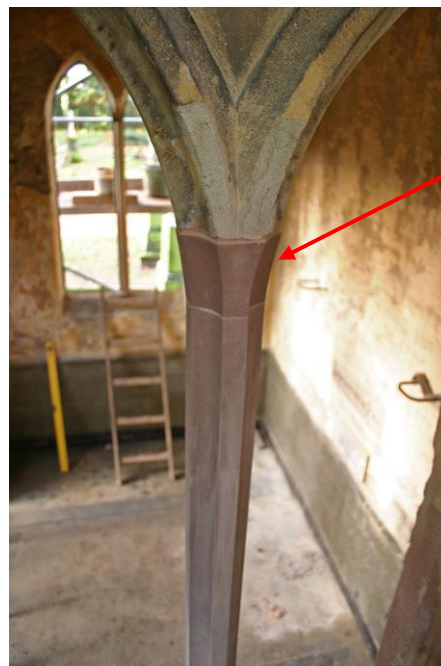
Neugefertigtes Mittelgewände mit Anfänger
