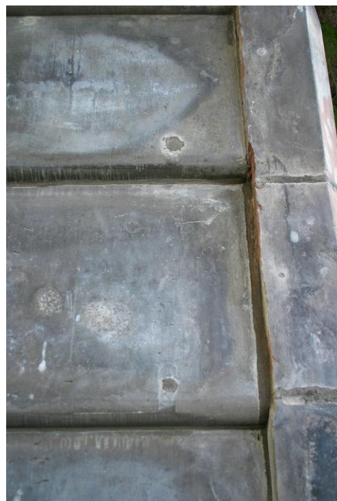
Linke Dachfläche mit neuer Verfugung
