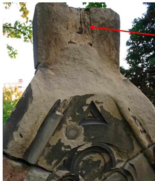
Massive Schädigung der Wimpergspitze durch Rostsprengung
