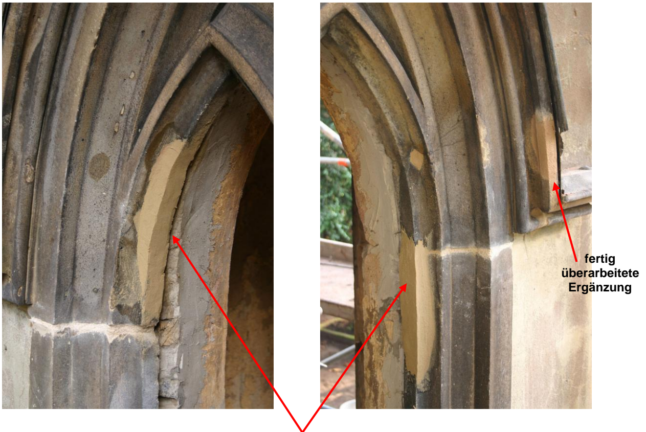
Gerade erst angetragene Restauriermörtelstellen am Fenstergewände
