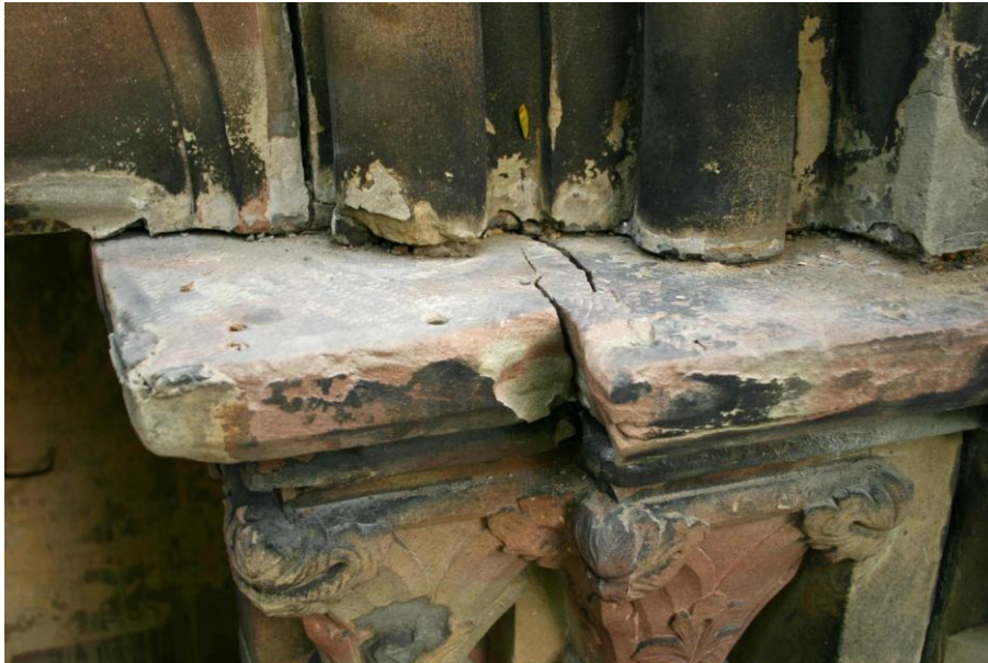
Schadenssituation nach der Reinigung
