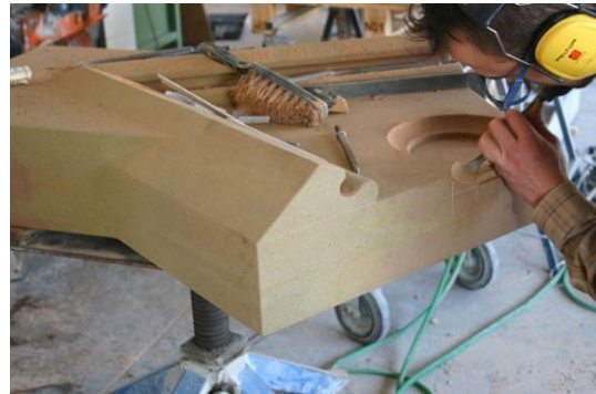
Nach der Ausarbeitung des Gesimsprofil wird das Vierpass-Segment ausgearbeitet
