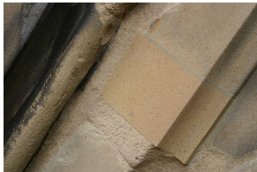
in der Giebelfläche eingebaute Vierung
