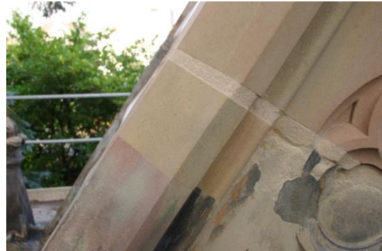
D. fertig eingebaute Vierung
