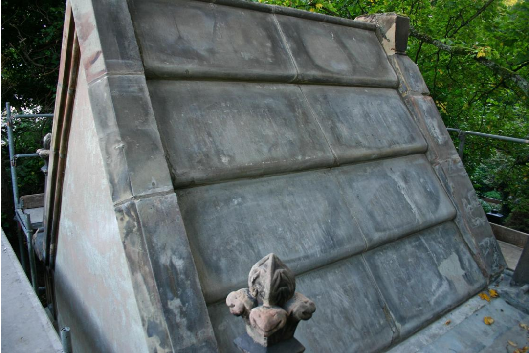
Linke Dachfläche mit neuer Verfugung
