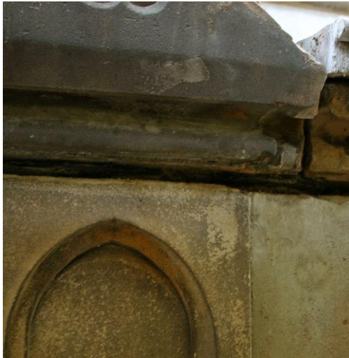
Dachgesims mit ausgestemter Fuge
