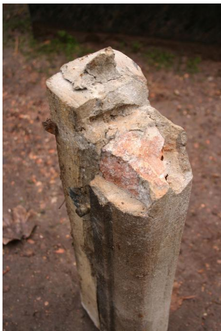
Aus Ziegel und Zementputz gefertigtes Fenstergewände
