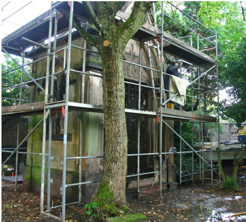
zu Beginn der Reinigungsarbeiten
