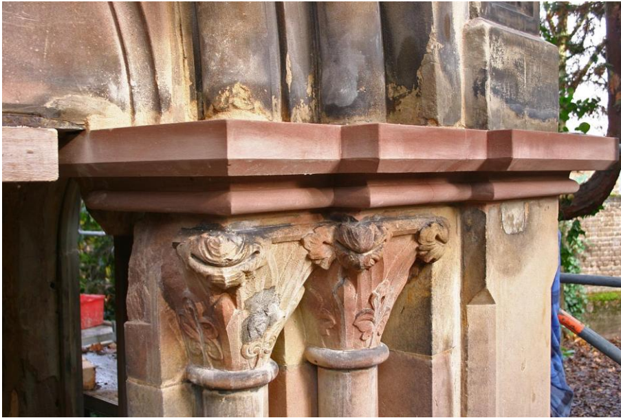
Fertig eingebaute neue Kapitellabdeckung aus rotbraunem Eifelsandstein
