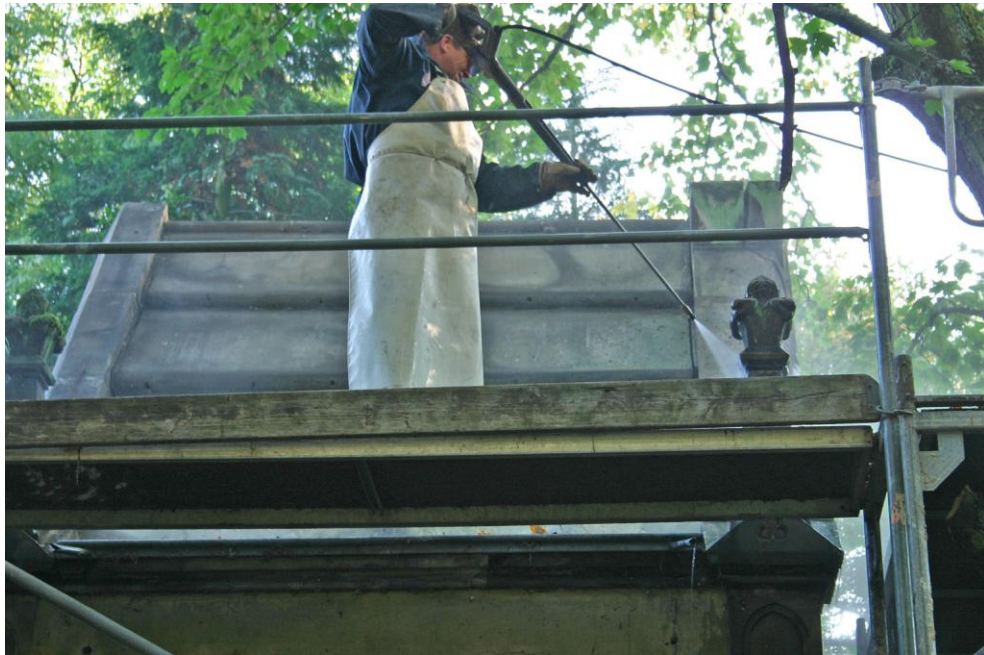
Reinigung der Dachfläche
