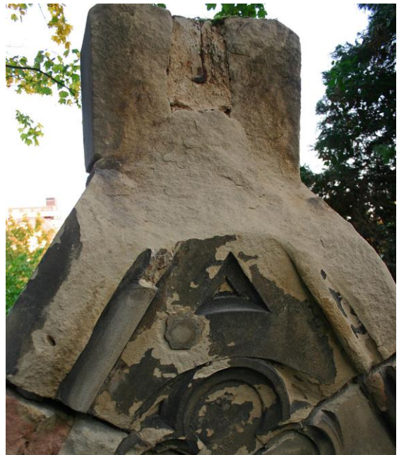
Wimperg-Situation nach der Reinigung
