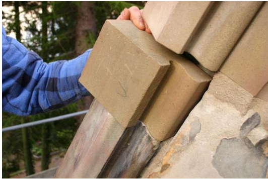
C. Vierungsstück in der Einpassphase
