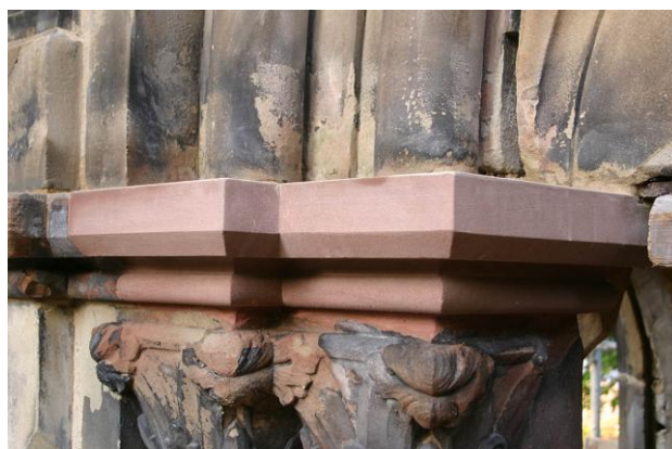
in der Giebelfläche eingebaute Vierung
