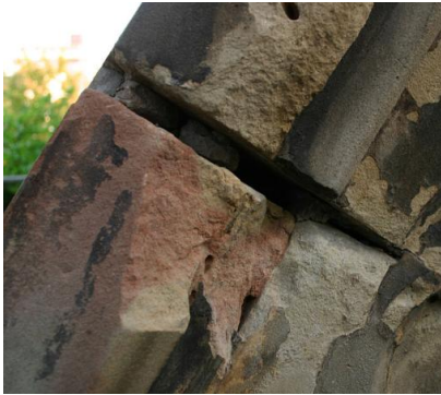
A. Schadstelle am Wimperg Außengesims
