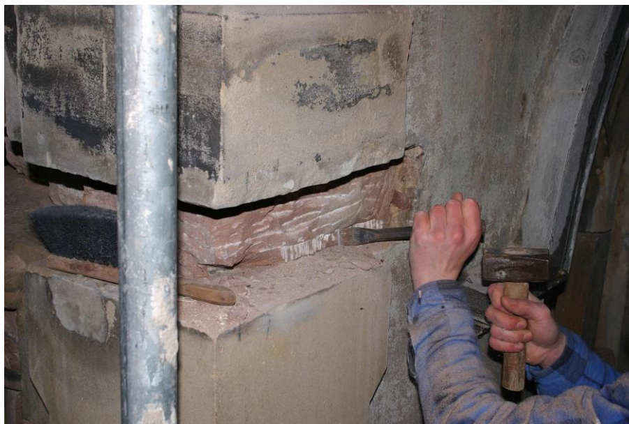
Beim Ausstemmen blieb zur Sicherheit der innere Bereich im Mauerwerk erhalten
