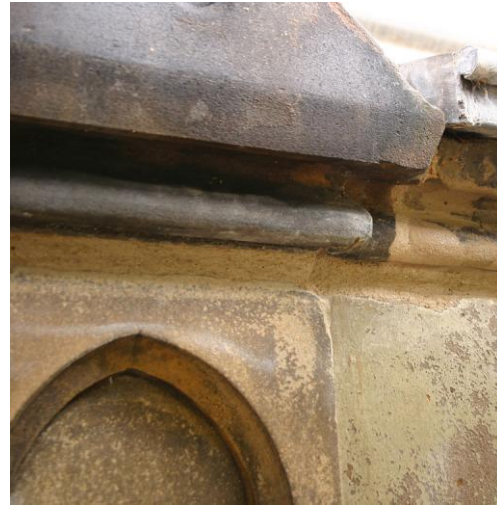
Mit neuer Fugenfüllung
